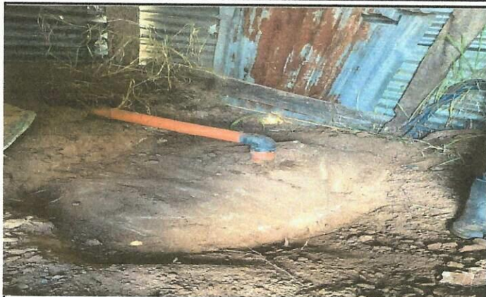
Foto 1: Se realizara el mejoramiento de la losa septica.
