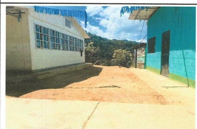
Foto 4: Se realizara el mejoramiento de la losa de concreto.
