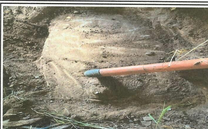
Foto 2: Se realizara el mejoramiento de la losa septica.
